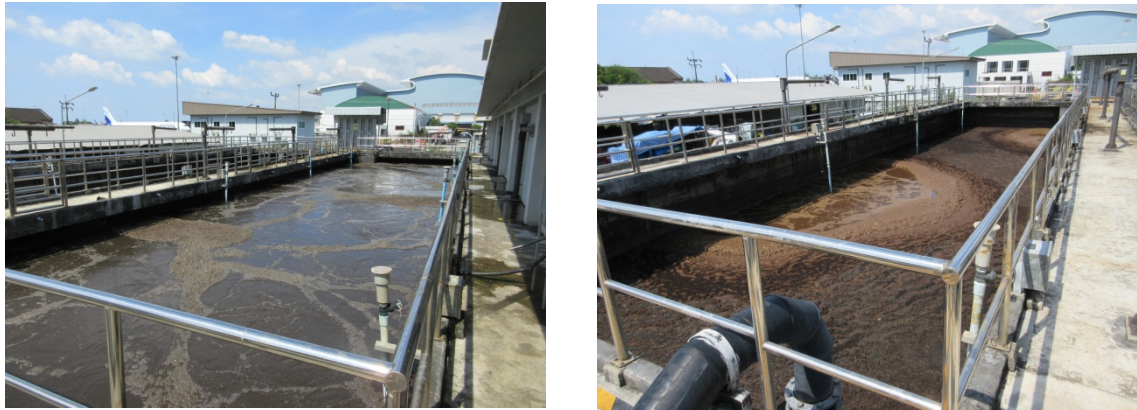
รูปที่ 2.3-10 ถังเติมอากาศ (Aeration Tank)
