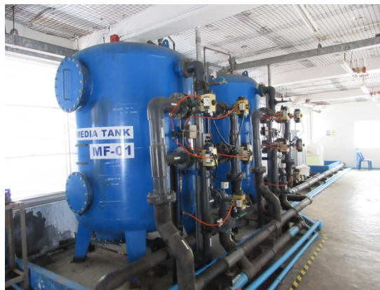
รูปที่ 2.3-14 ถังกรองแบบปิดทรงกระบอกแนวตั้ง (Vertical Pressure Filter)
